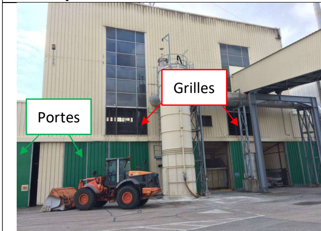
Façade Est – Bâtiment « Four »
