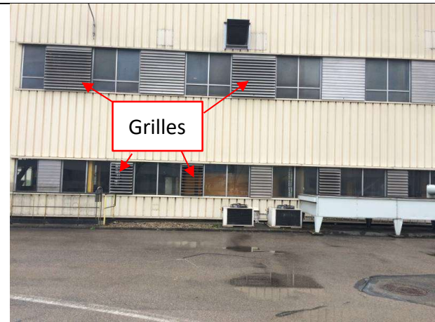
Façade Est – Bâtiment « Machines »
